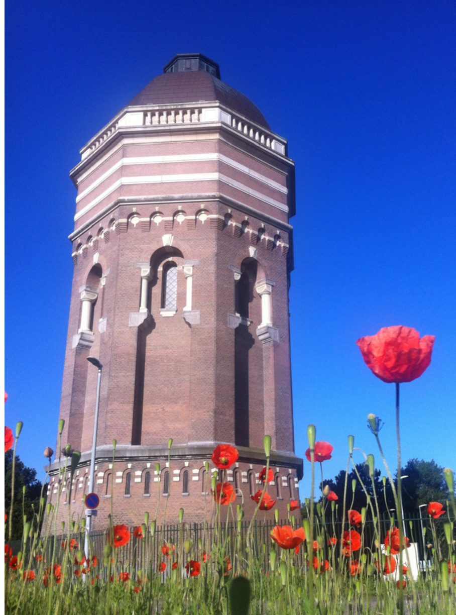
Foto: Watertoren Dunea Scheveningen. De watertoren zorgt ervoor dat er continu druk blijft staan op het waterleidingnet - ook bij een eventuele stroomuitval.
